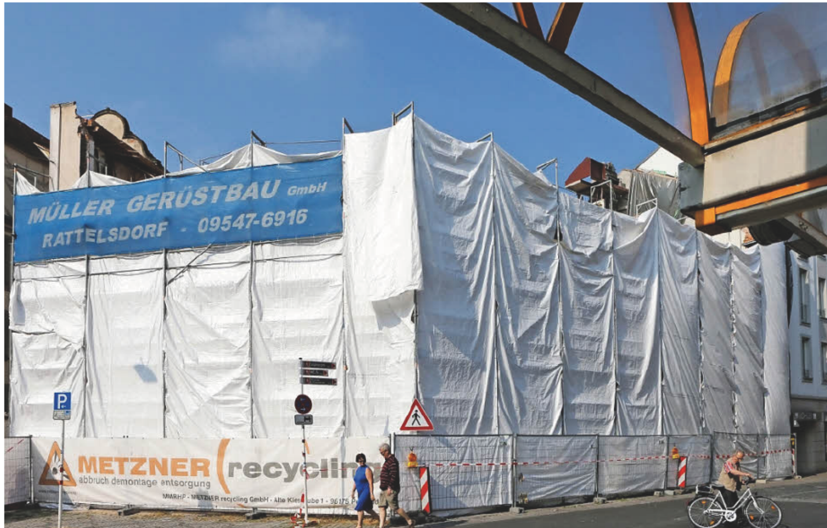
Das Dach ist schon weg: Am ehemaligen Metzner-da-am-Eck-da-Haus beim ZOB hat der Abbruch begonnen.
