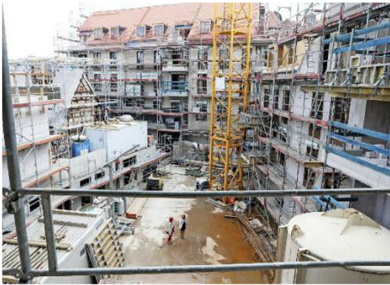
Blick in den Innenhof des Quartiers mit alter und neuer Bausubstanz
